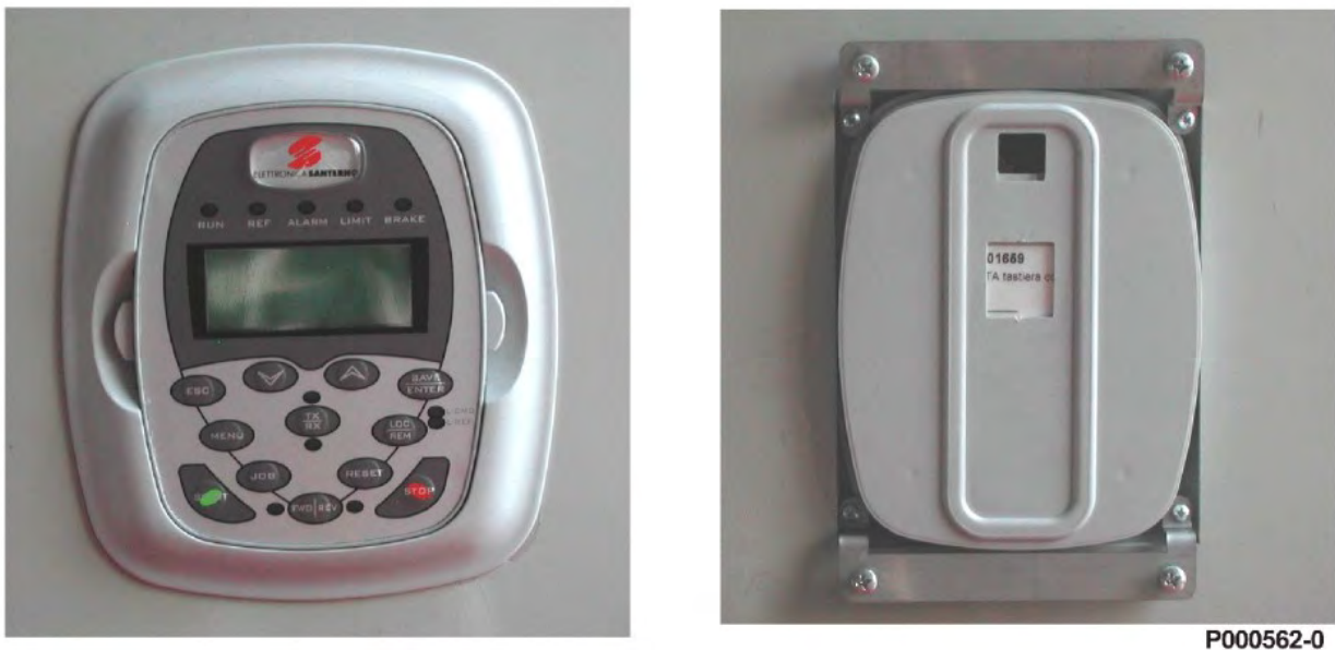
Figura 81: Viste anteriore / posteriore della tastiera e relativo guscio, fissati sul pannello.
